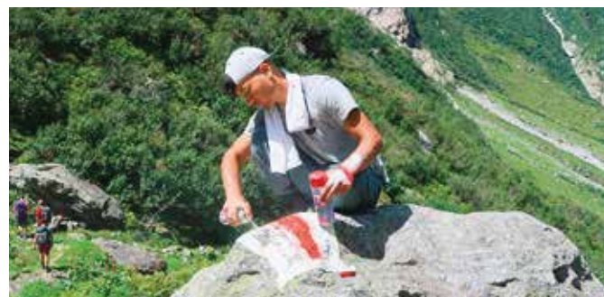
Wegarbeiten am Gaulizustieg.
